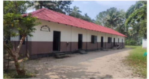
MGM LPS KARUVATTAMKUZHI
